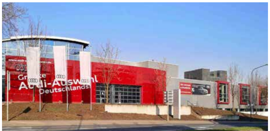
Die Fassade des Audi Zentrums Essen vor der Sanierung mit kleinteiligeren Fassadenplatten.
